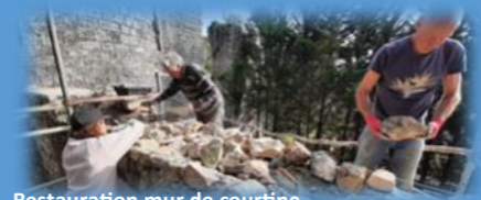
Restauration mur de courtine
